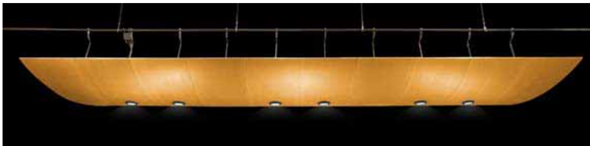
天井音響反射板の全体像
