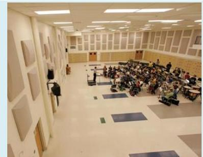
吸音パネルと拡散パネルでトリートメントがなされた練習室
